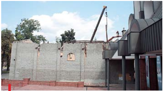
Kościółek w trakcie rozbiórki
