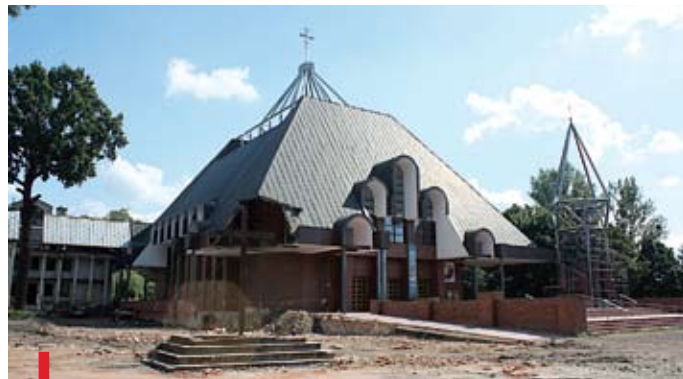
Widok nowego kościoła po rozbiórce starego
